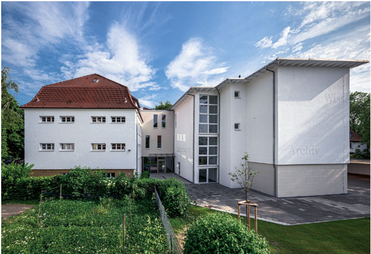
Seitenansicht des neuen Stadt- und Kreisarchivs Gütersloh (Foto: Detlef Güthenke)
