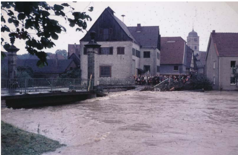
Die Almebrücke in Schloß Neuhaus kann dem Druck nicht standhalten und zerbricht in den frühen Morgenstunden des 17. Juli. (Foto: Kreisarchiv Paderborn)
