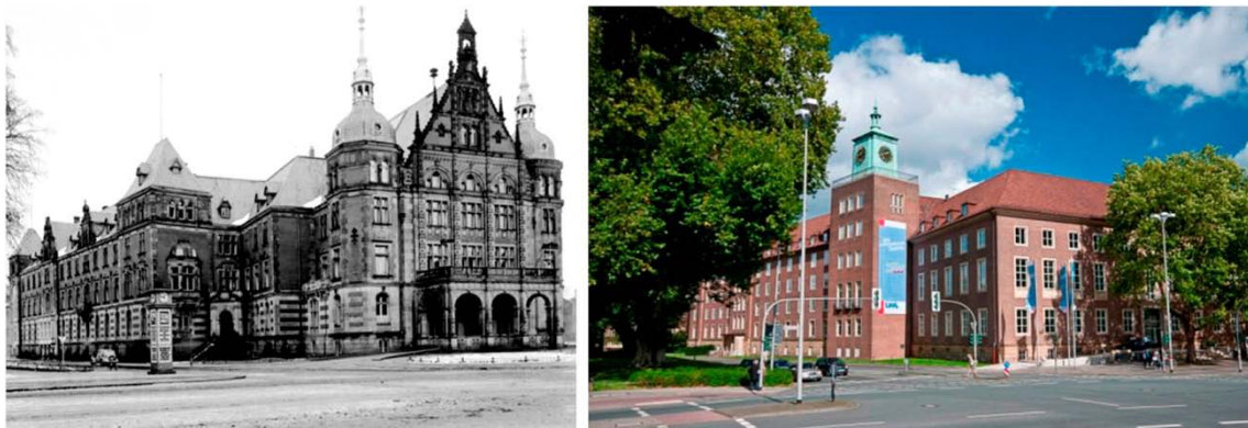
Das alte Landeshaus wurde 1901 fertiggestellt und im Zweiten Weltkrieg in Teilen zerstört. Rechts: Das Landeshaus heute. (Fotos: LWL/Medienzentrum und LWL/Arendt)
