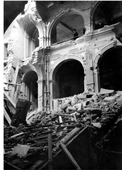
Treppenhaus nach dem Luftangriff am 10. Oktober 1943. (Foto: LWL/ Medienzentrum)
