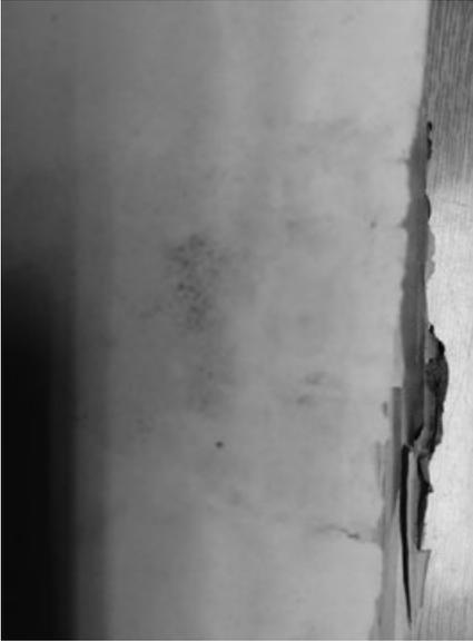
*Abb. 4: Nach der Trockenreinigung bleiben durch Schimmelpilzbefall verursachte Verfärbungen sichtbar, es gibt aber keine aktiven Schimmelsporen mehr.*
